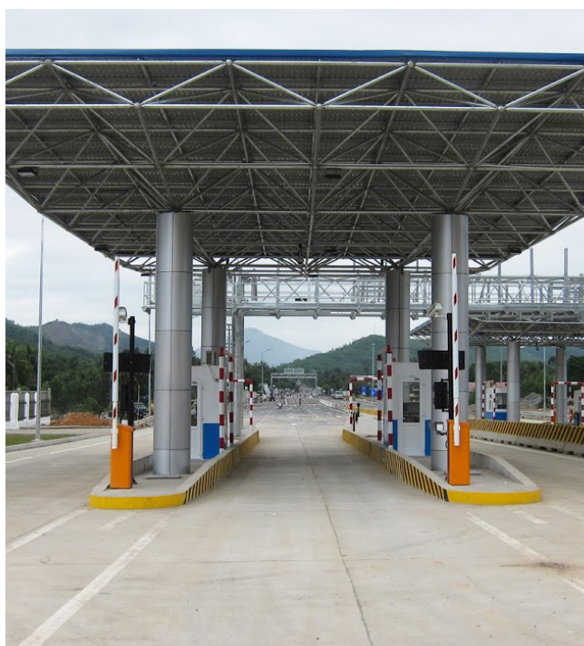
HỆ THỐNG THU PHÍ HẦM CÙ MÔNG TOLL COLLECTION SYSTEM (CU MONG TUNNEL)
