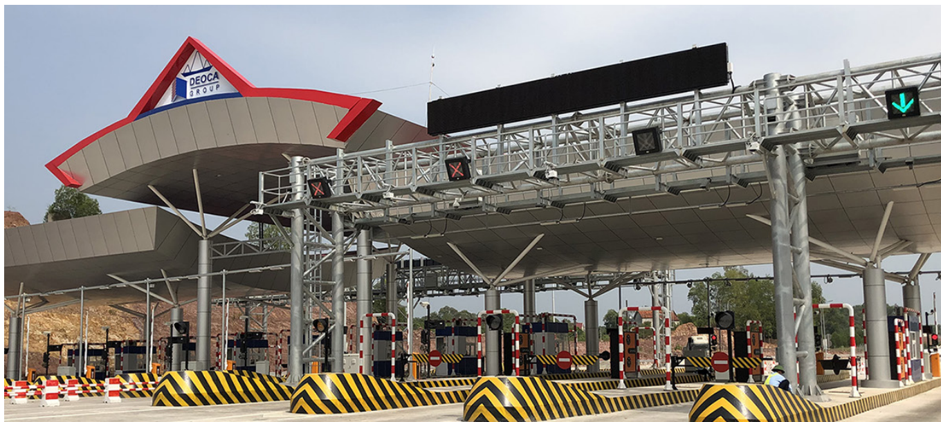
HỆ THỐNG THU PHÍ TỰ ĐỘNG (CAO TỐC BẮC GIANG - LẠNG SƠN) ETC SYSTEM (BAC GIANG - LANG SON EXPRESSWAY)
