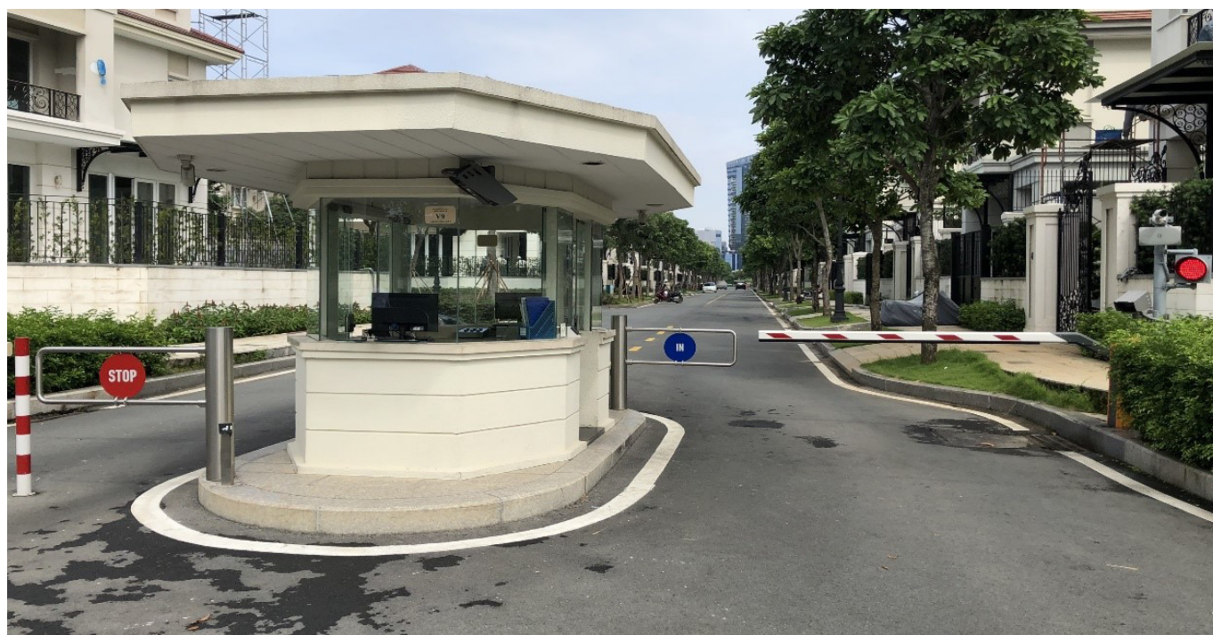
HỆ THỐNG KIỂM SOÁT VÀO RA KHU ĐÔ THỊ (SALA - ĐẠI QUANG MINH) ACCESS CONTROL SYSTEM FOR RESIDENTIAL AREA (SALA CITY - DAI QUANG MINH)
