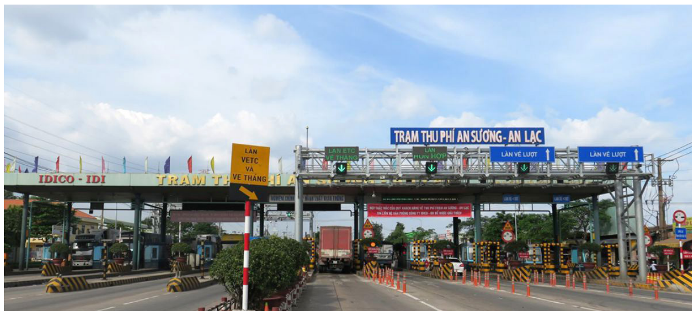
HỆ THỐNG THU PHÍ TỰ ĐỘNG (AN SƯƠNG - AN LẠC) ETC SYSTEM (NATIONAL ROUTE 1 THROUGH AN SUONG - AN LAC)
