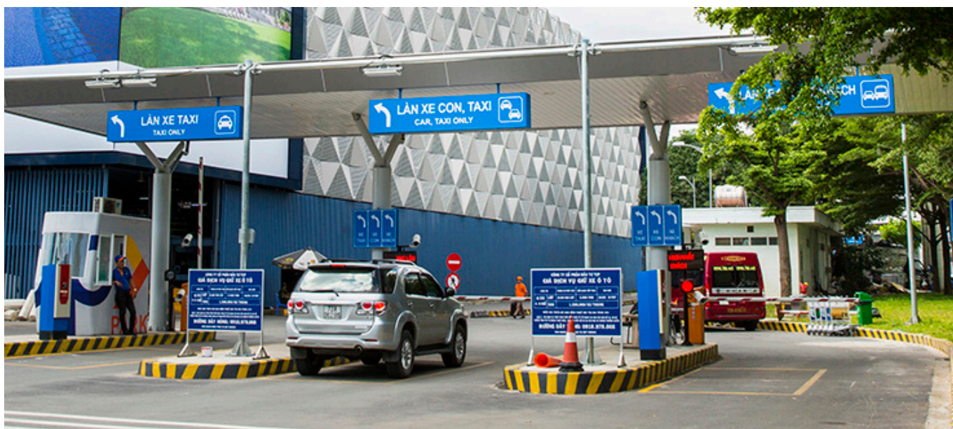
HỆ THỐNG KIỂM SOÁT & HƯỚNG DẪN ĐỖ XE ( NHÀ GA T1 SÂN BAY TÂN SƠN NHẤT) PARKING CONTROL & GUIDANCE SYSTEM (T1 TERMINAL TAN SON NHAT INTERNATIONAL AIRPORT)
