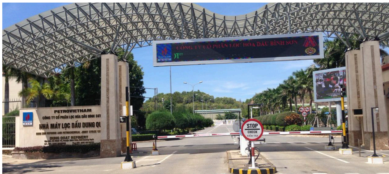
HỆ THỐNG KIỂM SOÁT VÀO RA NHÀ MÁY LỌC DẦU (BSR - DUNG QUẤT) ACCESS CONTROL SYSTEM FOR REFINERY (BSR - DUNG QUAT)
